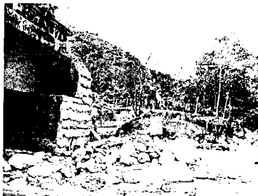
Foto 2. Pérdida de la aleta y Banca de acceso.
